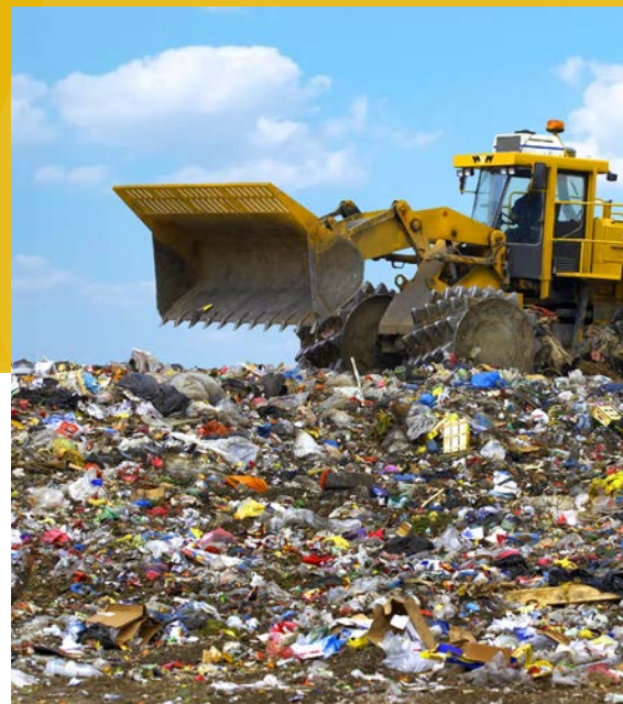
Rekultywacja składowisk odpadów i terenów zdegradowanych
