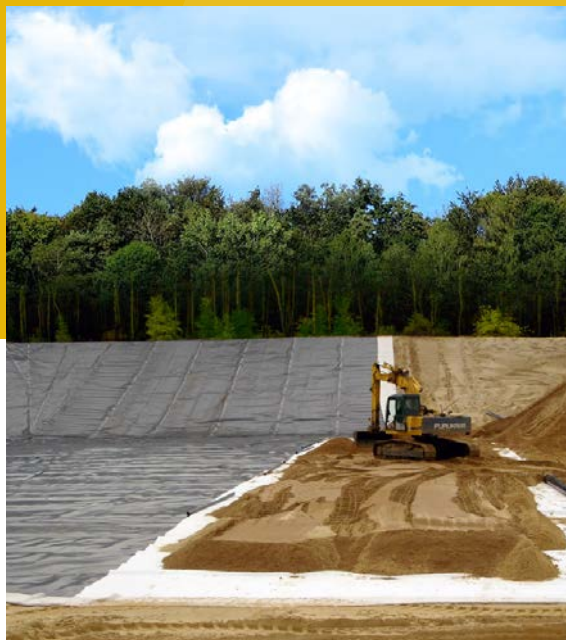
Prowadzenie procesu budowy składowisk odpadów
